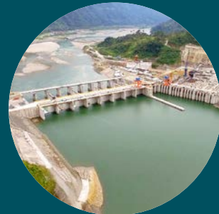
Proyecto propósito hi- droeléctrico Coca Codo Sinclair
