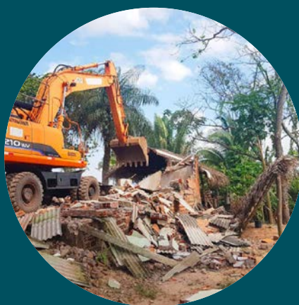
Ampliación del puerto São Luís
