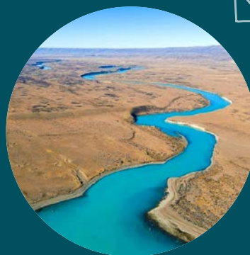
Proyecto hidroeléctrico Río Santa Cruz
